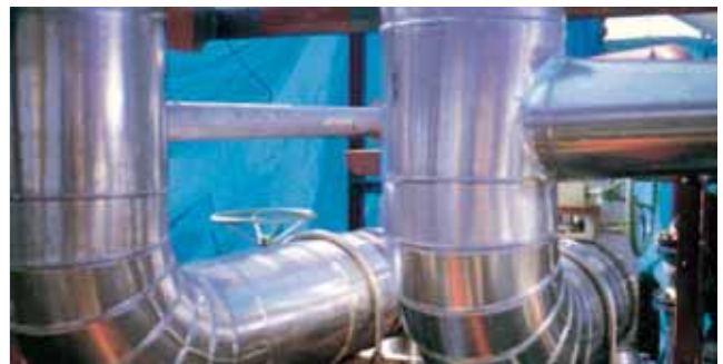
SUS Cladding Erection
